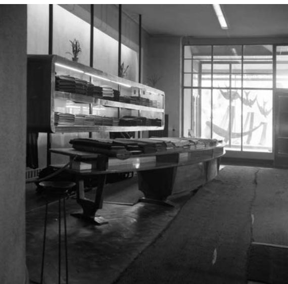
64. Wnętrze Domu Mody we Wrocławiu, proj. Władysława Winczego, 1957
