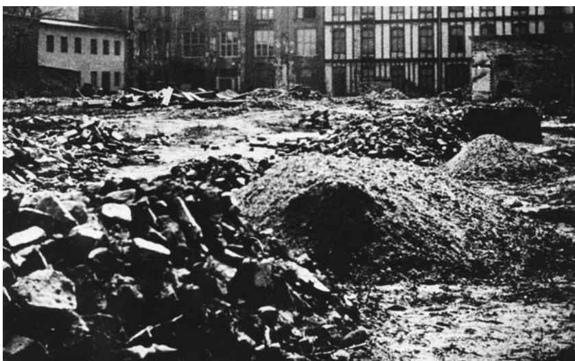
20. Budynki PWSSP przy ul. Traugutta przed uporządkowaniem terenu, 1946
